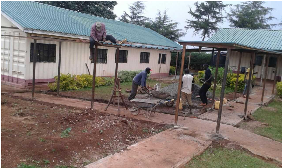
Bau überdachter Verbindungswege zwischen den Gebäuden
