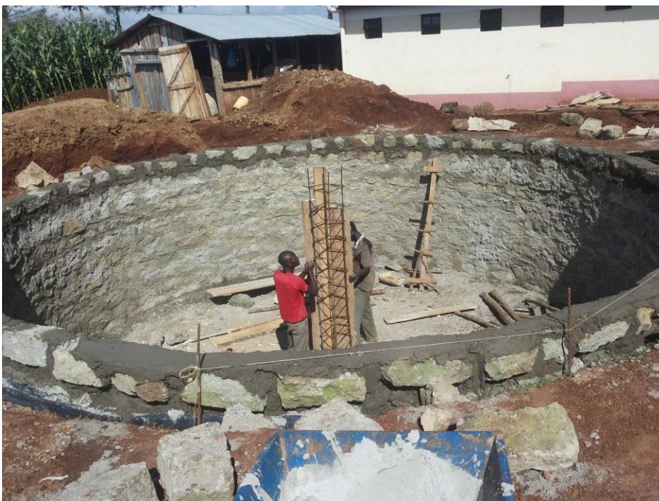
Bauarbeiten für den Regenwassertank
