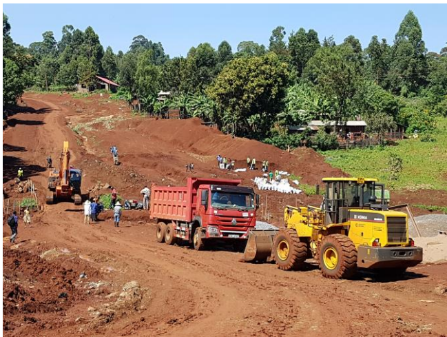
Bauarbeiten zwischen Kapsokwony und Sambocho
