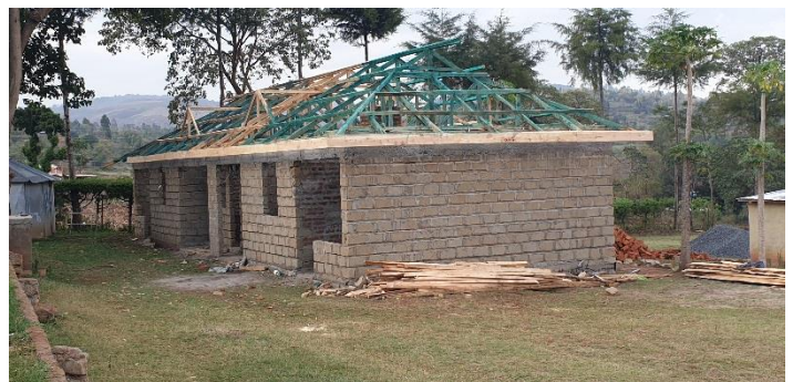
Der Rohbau des ersten Mitarbeiterhauses
