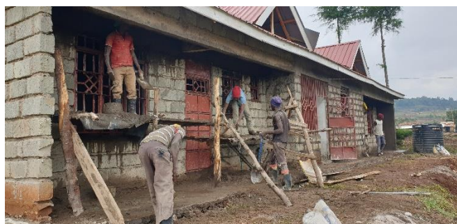
Gipsarbeiten am Mitarbeiterhaus
